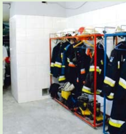
W remizie OSP wyremontowane zostały pomieszczenia
