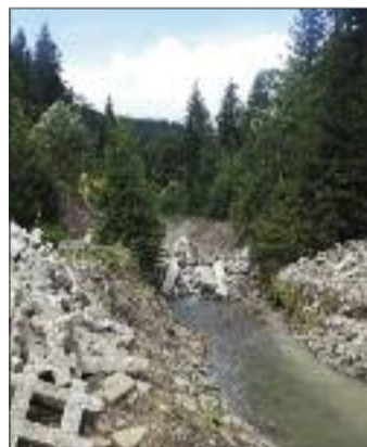
Ujęcia wody przed modernizacją
