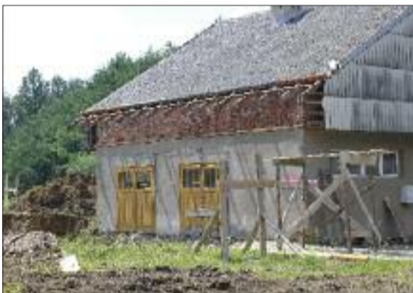
Stacja uzdatniania wody
