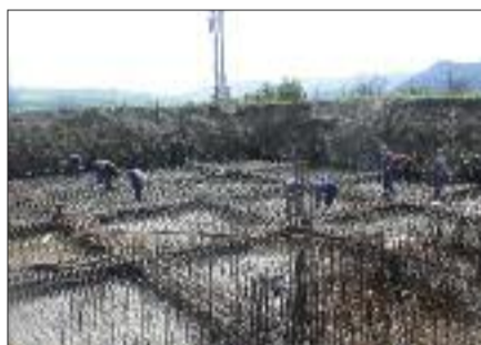
Budowa nowego zbiornika
