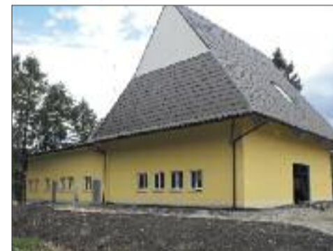
Budynek stacji uzdatniania wody
