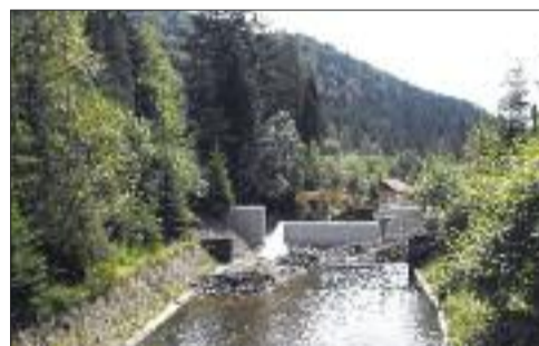
Modernizacja ujęcia wody
