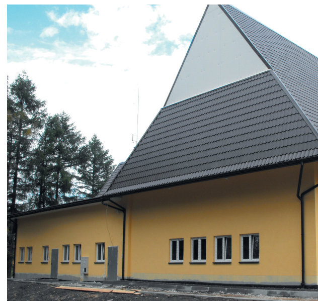
Budynek stacji uzdatniania wody
