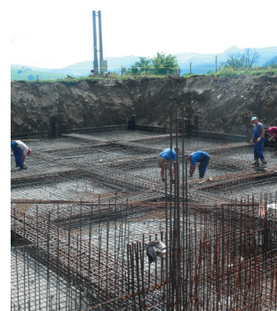
Budowa nowego zbiornika
