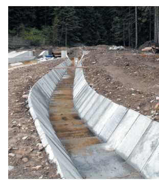
Modernizowane ujęcia wody: Przepławka dla ryb – kanał wód burzowych
