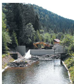
Modernizacja ujęcia wody
