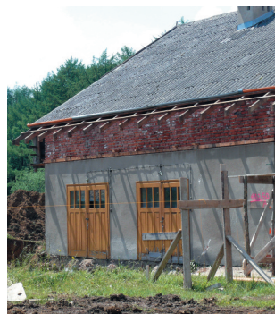
Stacja uzdatniania wody
