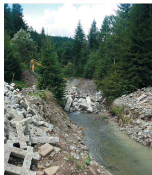
Ujęcia wody przed modernizacją
