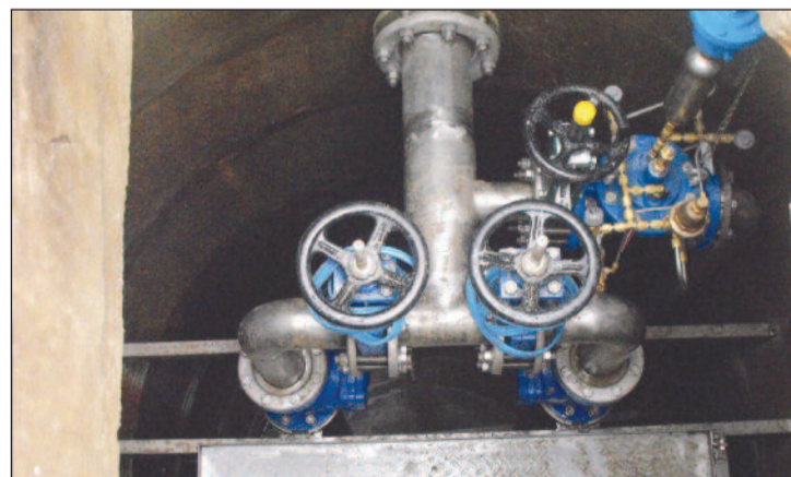
Studnia pompowna wraz z wyposażeniem, która będzie przepompowywać wodę z ujęcia „Sewerynówka” na SUW. Aktualne zdjęcia z realizacji robót w ramach projektu można obejrzeć na stronie www.szczawnica.pl
