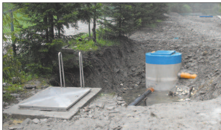
Studnia pompowna wraz z wyposażeniem, która będzie przepompowywać wodę z ujęcia „Sewerynówka” na SUW. Aktualne zdjęcia z realizacji robót w ramach projektu można obejrzeć na stronie www.szczawnica.pl
