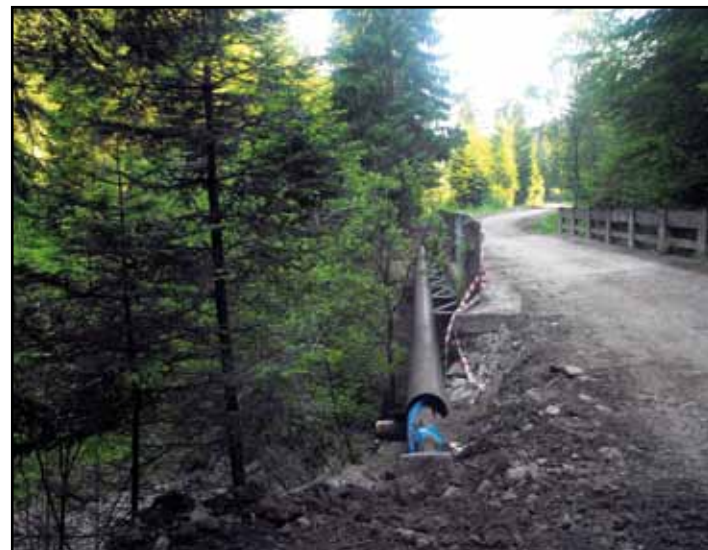
Montowane podwieszenia na mostkach
