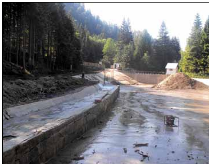
Osuszone ujęcie oczekujące na remont
