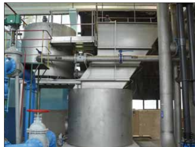
Dolna część filtra, przewidziana do montażu
