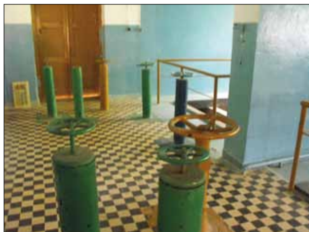
Istniejąca hala zasów
