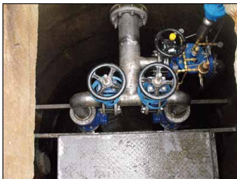
Na zdjęciu: studnia pompowna wraz z wyposażeniem, która będzie przepompowywać wodę z ujęcia sewerynowka na SUW. Aktualne zdjęcia z realizacji robót w ramach projektu można obejrzeć na stronie www.szczawnica.pl
