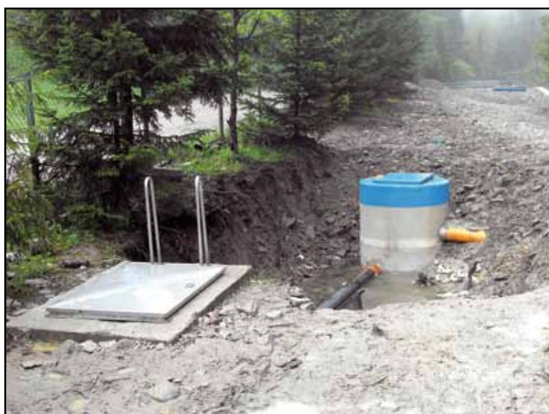
Na zdjęciu: studnia pompowna wraz z wyposażeniem, która będzie przepompowywać wodę z ujęcia sewerynowka na SUW. Aktualne zdjęcia z realizacji robót w ramach projektu można obejrzeć na stronie www.szczawnica.pl
