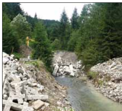
Ujęcia wody przed modernizacją
