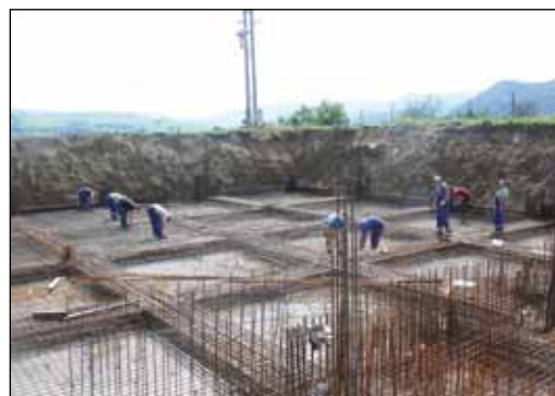
Budowa nowego zbiornika
