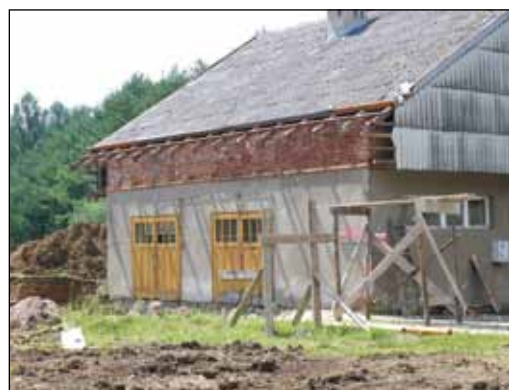
Stacja uzdatniania wody
