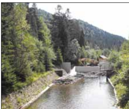
Modernizacja ujęcia wody
