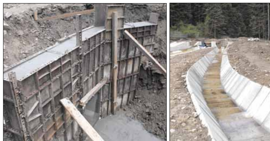
Przepławka dla ryb – kanał wód burzowych
