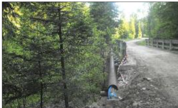
Montowane podwieszenia na mostkach
