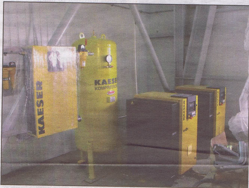
Aparatura do wytwarzania powietrza na potrzeby procesów technologicznych
